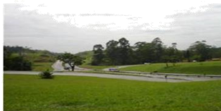
UIT 2 – Trecho Dutra Km 190
