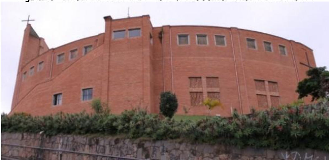
Figura 13 – FACHADA LATERAL – IGREJA NOSSA SENHORA APARECIDA
